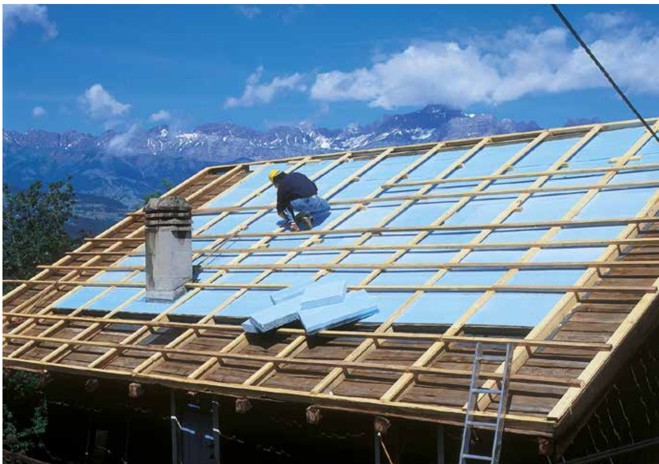
Ejemplo de RAVATHERM XPS SB instalado en cubierta inclinada entre rastreles
